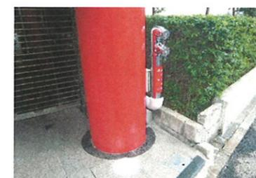
連結送水管とは、消火作業時に消防隊が使用する設備です。消防法により、設置してから10年後より3年毎に、耐圧試験が義務付けられています。長年使用していないと、経年劣化による腐食で漏水する場合がある為、非常時に非常設備が使用出来るように、日々の点検と、定期的なメンテナンスを行っております。
